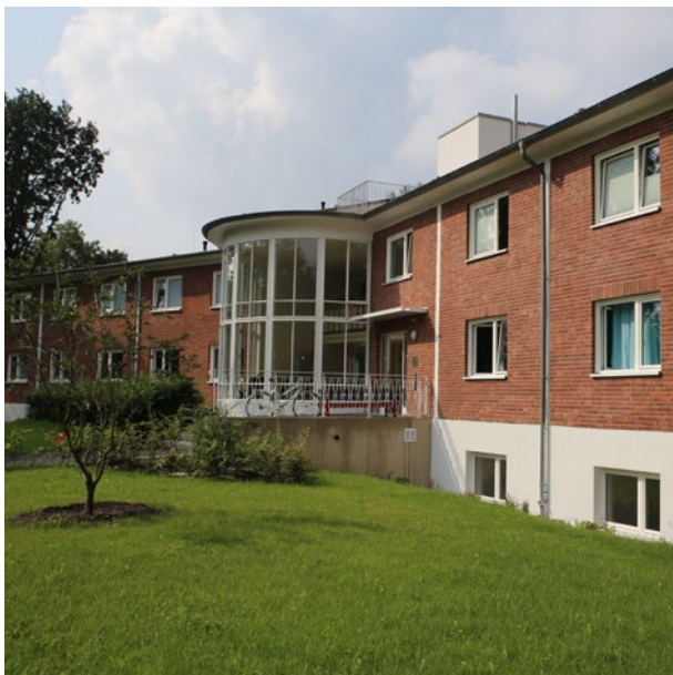
Außenansicht des Markushauses
